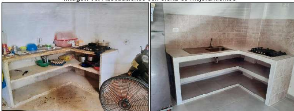
Imagen 16. Adecuaciones con oferta de mejoramientos
