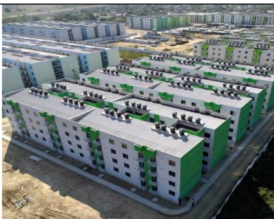
Figura 13. Vista frontal CLP etapa 3,4 y 5
