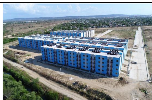
Figura 5. Bloques manzana A Y B
