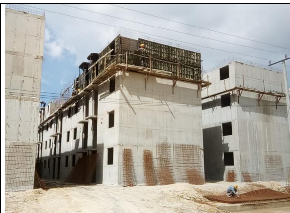
Figura 14. Armado de formaletas y acero para muros y placas
