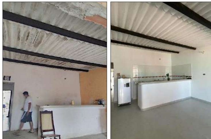
Imagen 9. Mejoramiento de Vivienda Antes y Después
