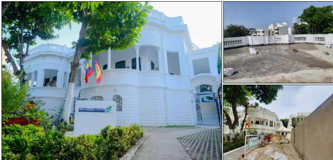
Imagen 15. Casa Mogollón y Actividades de Obra Civil
