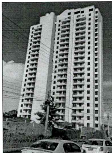
Imagen 19. Torre del Proyecto Bahía San Carlos
