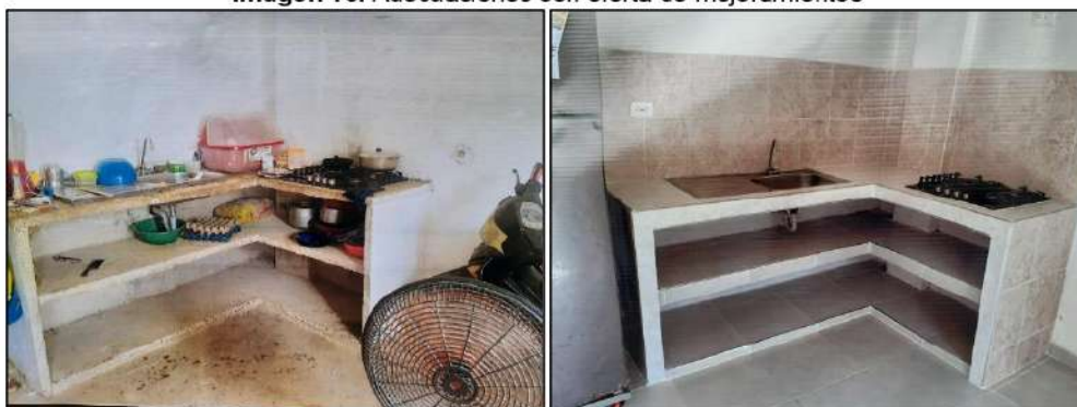
Imagen 16. Adecuaciones con oferta de mejoramientos
