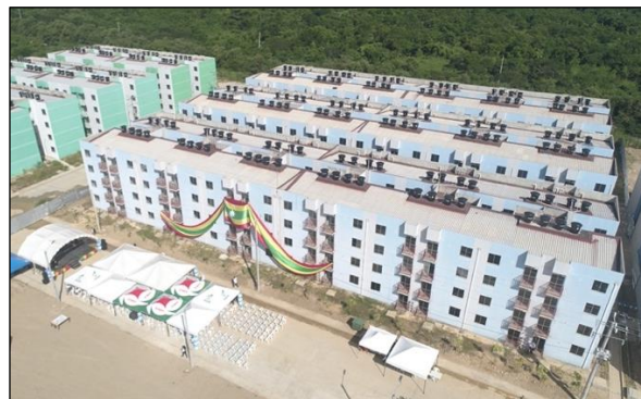
Fuente. Equipo de Comunicaciones
